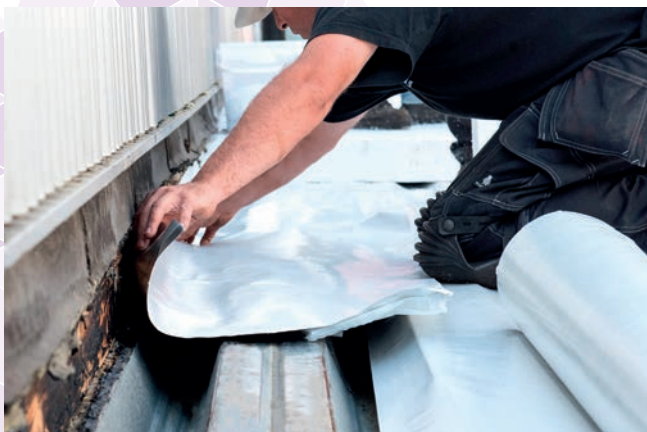
Aansluiting dampremmende laag bij gevel.
