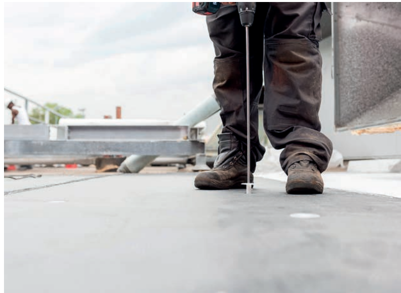
Mechanisch bevestigen van de eerste laag.
